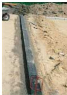
Usazení žlabových těles do betonového lože
