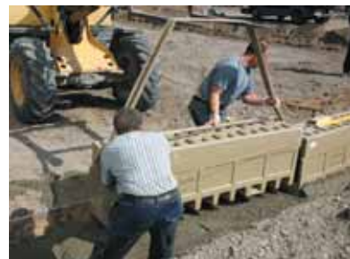
ACO DRAIN® Monoblock RD 300 během montáže
