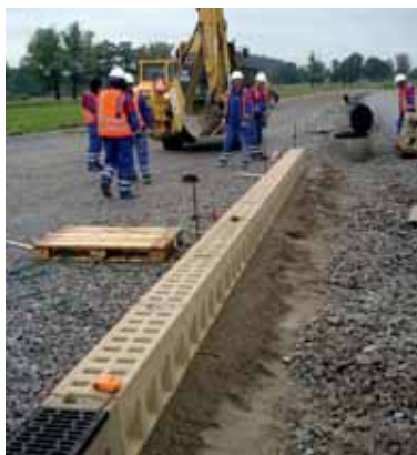
Rychlostní komunikace R4 - Písek, ACO DRAIN® Monoblock RD 200 V
