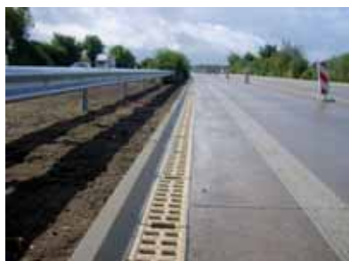
ACO DRAIN® Monoblock RD 200 V na dálnici jako podélné odvodnění
