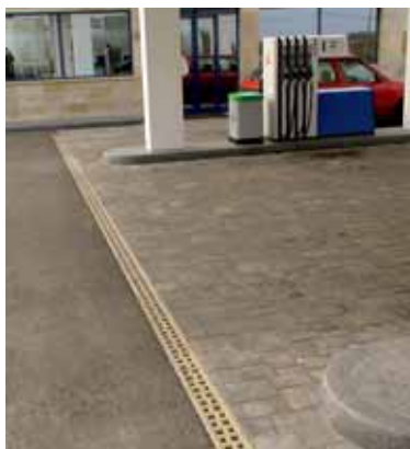
Čerpací stanice Tůmovka, ACO DRAIN® Monoblock RD 100 V
