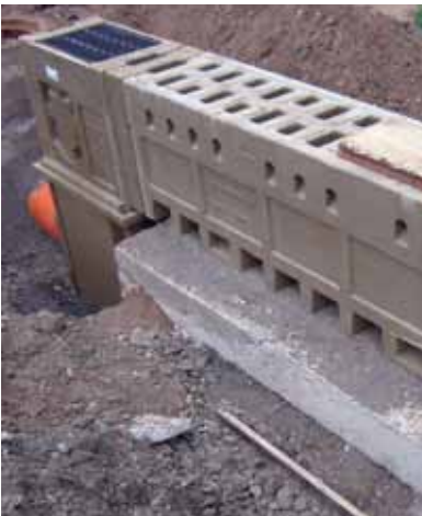
ACO DRAIN® Monoblock RD 300 DF na dálnici
