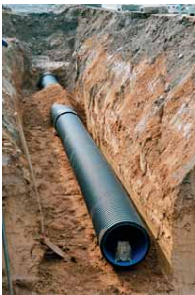
Instalace systému Aqua-pipe na čerpací stanici s odpočívadlem Medenbach.
