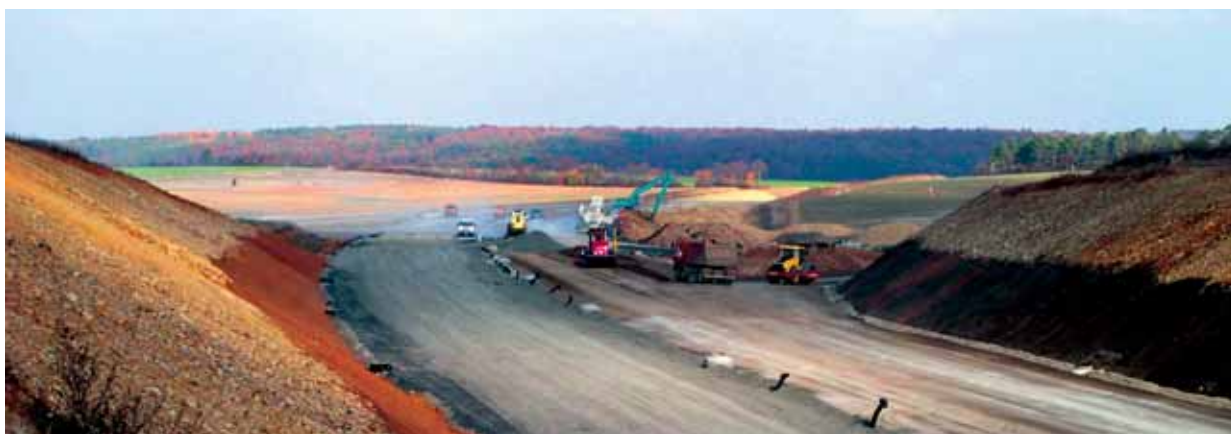
Novostavba A 71 – instalace systému Aqua-pipe
