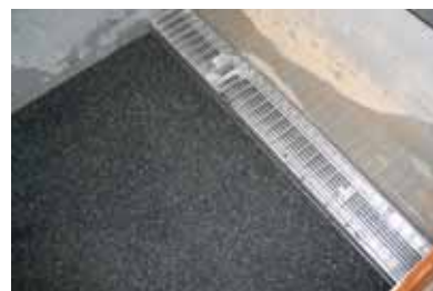
Štěrkové lože se štěrskem drčeným na velikost 2/5 mm
