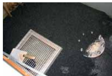
Zkušební instalace s odvodňovací výztuží a ložem z drčeného štěrku před přístupovým rámem k výstupu
