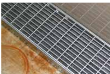
Vložená tkanina pro zachycování nečistot snižuje již v čistém stavu hydraulické parametry systému o 30%
