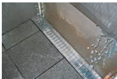
Beregnung der Fassadenrinne im Einbau
