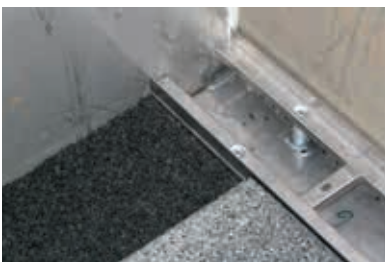
Rinnensystem lose verlegt
