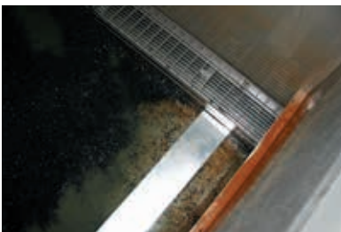
Prüfungsaufbau mit seitlich angesetztem Stichkanal (ohne Ausschnitt im Rinnenkörper)
