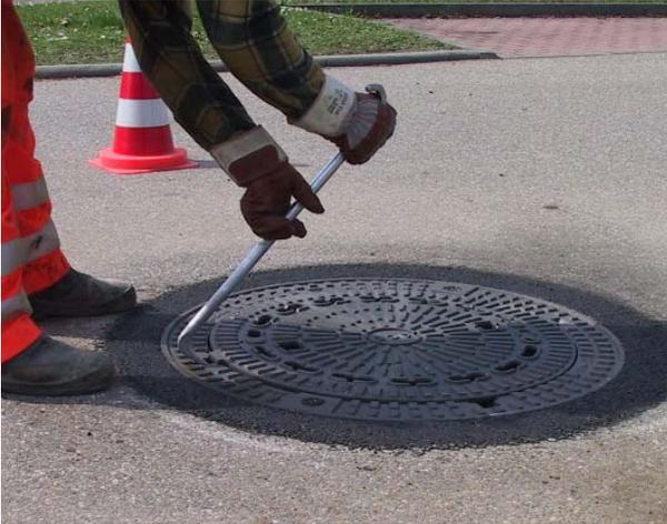
Bedienungsschlüssel an den Entriegelungsöffnungen am Rahmen einsetzen, und mit einer Hebelbewegung nach außen den Deckel entriegeln.
