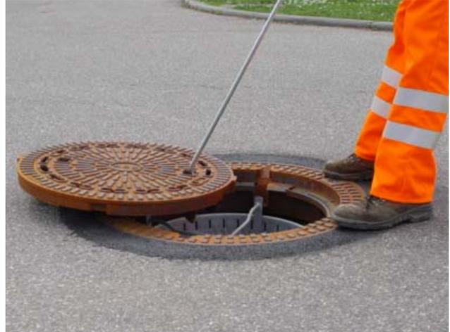
Auflageflächen an Deckel und Rahmen reinigen. Deckel, Rahmen, dämpfende Einlage und Verriegelungsnocken auf Beschädigungen überprüfen. Deckel unter Beachtung der Einlegesicherung einlegen.
