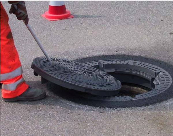
Anschließend den Deckel mit dem Bedienungsschlüssel an den Aushebeöffnungen herausziehen.
