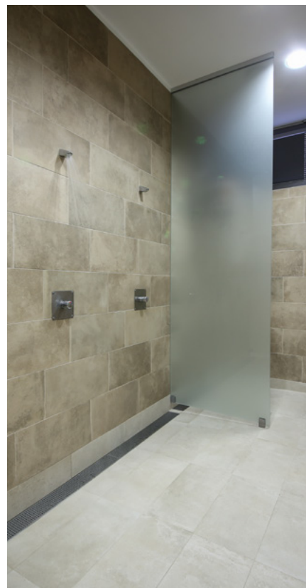
Bazén Nové Město na Moravě (ACO Krabicový žlab 125 s roštem Quadrato)
