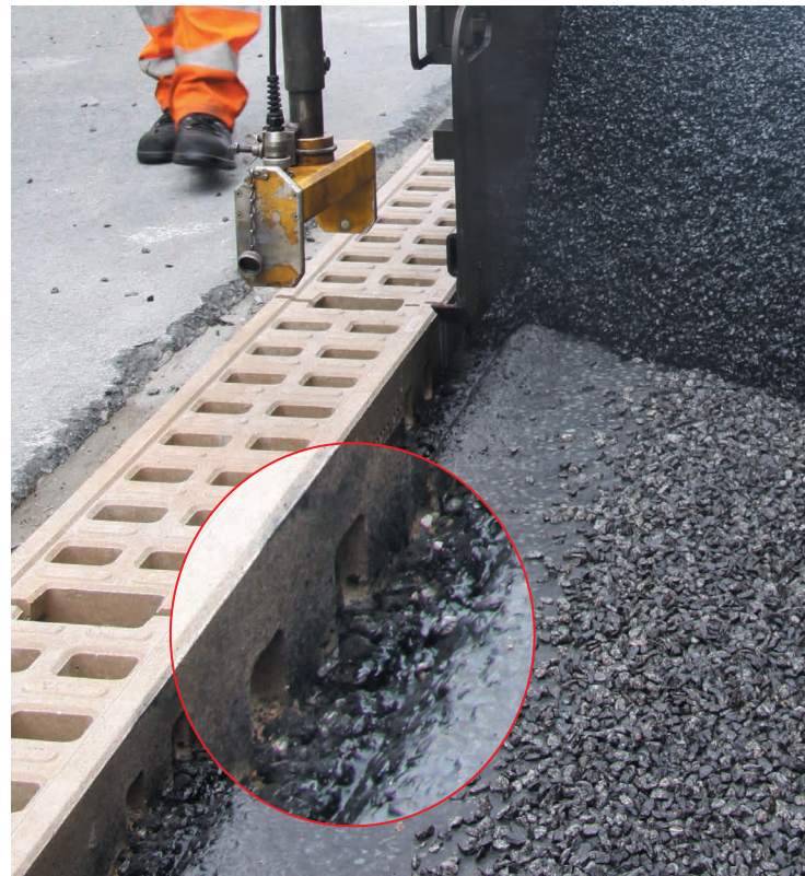
Entwässerung von offenporigem Asphalt
